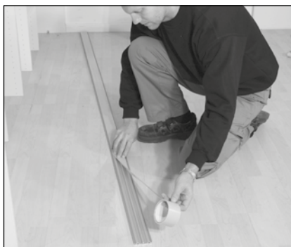
Plak de dubbelzijdige plakband onder de vloerrail.
