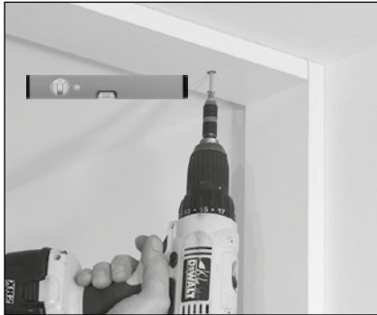
De boven strip wordt waterpas tegen het plafond gemonteerd. (Schroeven niet inbegrepen.)
