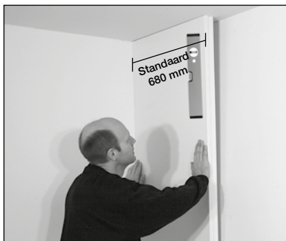
Plaatsing zijpaneel.
