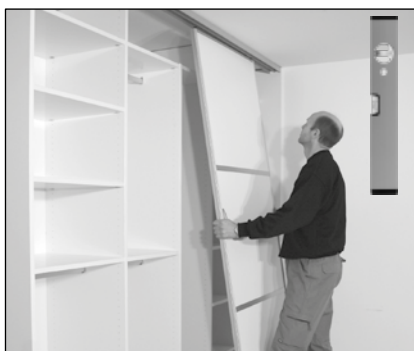
Plaats de deur in de binnenste boven- en vloerrail. De deur moet loodrecht zijn.
