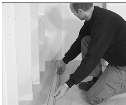
Plaats na het monteren van de bovenregel de vloerrail zonder tape tussen wanden / adapters / zijpanelen.
