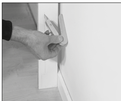
De vulstrook wordt aangepast aan de ongelijkheid van de muur zodat de ombouw zijpanelen loodrecht en waterpas gemonteerd kunnen worden.
